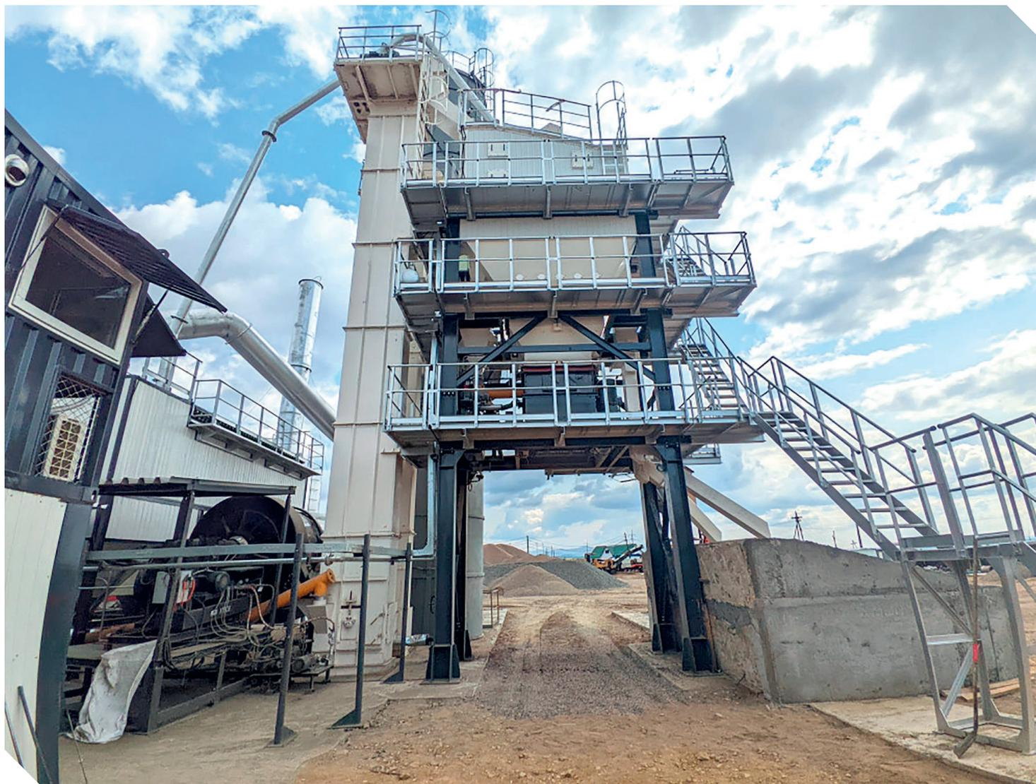
Поставка и запуск в эксплуатацию асфальтобетонного завода АММА АВР80 с бункером-накопителем готовой смеси. г. Хабаровск
