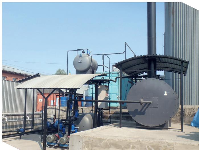
7. Реконструкция рамы сушильного барабана АБЗ Щпеко в г. Кемерово. Было произведено удлинение рамы для возможности размещения нового нестандартного сушильного барабана компании АММА.
