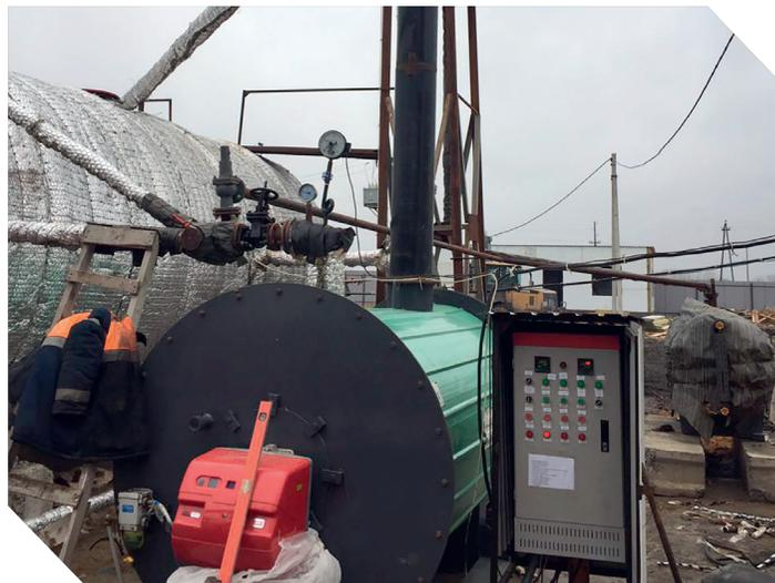
6. Станции подогрева термального масла с горелкой на мазутном топливе производительностью 350 000 кКал. г. Иркутск.
